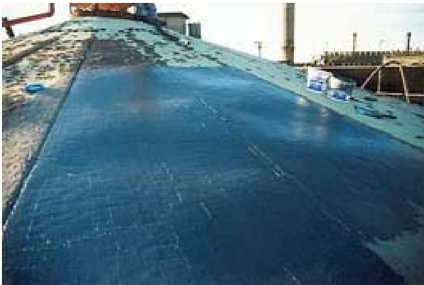
Après un sablage au standard SA2 ½ et un dégraissage à l'UNIVERSAL CLEANER Une couche de METAL-TECH EG a été passée sur tous les endroits faisant menace
