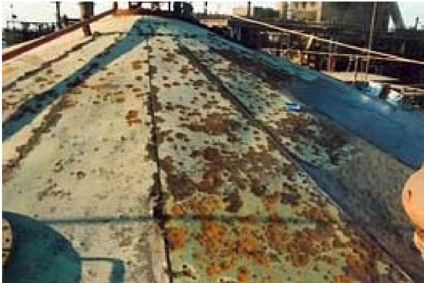
Une vue du toit de cuve avant intervention
