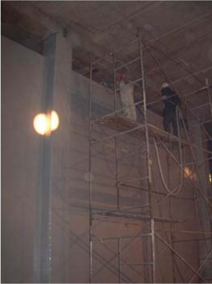
Vue des plafonds qui ont été tous traités de même manière que les murs
