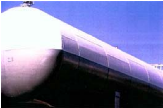
VUE APRES TRAITEMENT
