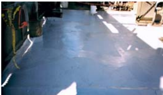
PHASE 6 Finition par passage au rouleau d'une couche de CHEMI-TECH CR de 250 \mu
