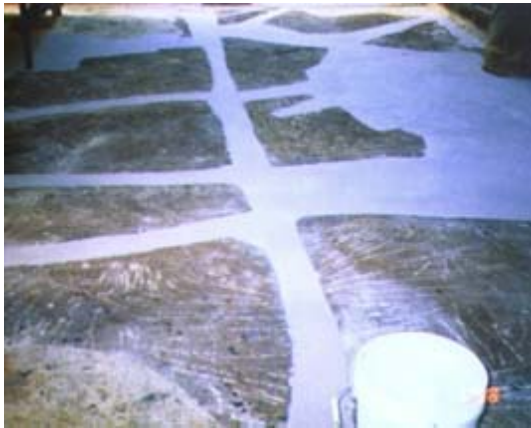
PHASE 5 Passage d'une couche de primaire primaire FLOOR-TECH SP PRIMER
