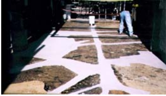
PHASE 4 Egalisation des surfaces à la règle
