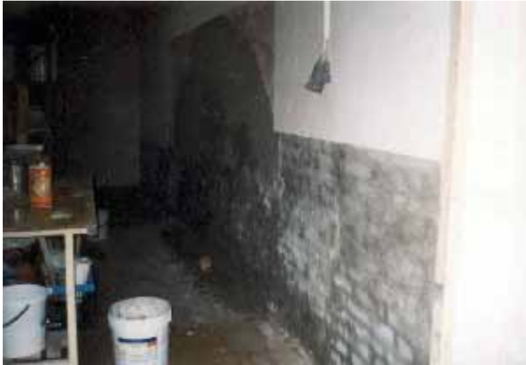
Ici en phase de reconstruction avec « Wall-Tech WB »
