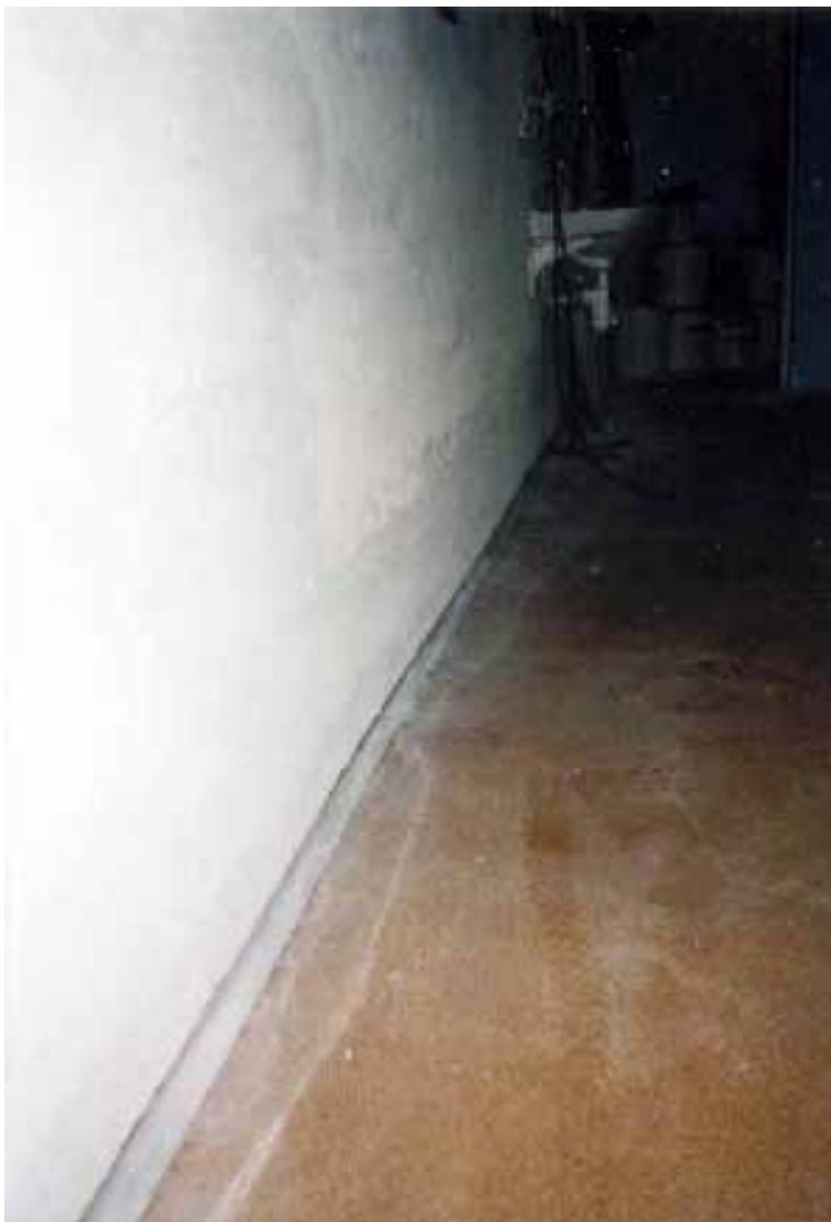
ICI LA VUE DU MUR COMPLETEMENT REFAIT
