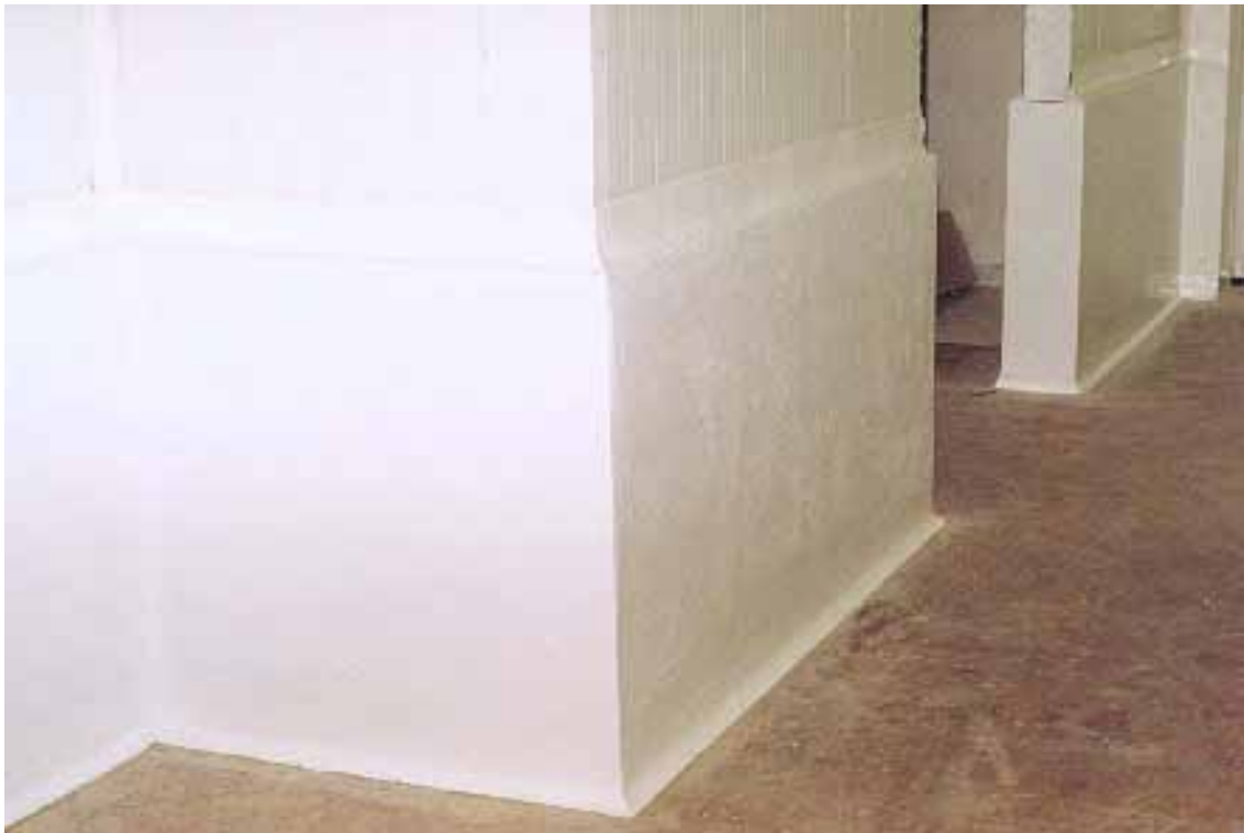
Une vue de la coursive ou les parties soumises aux chocs des chariots ont été reprises et renforcées au « Wall-Tech CSM »
