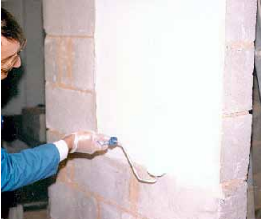
Phase 3 : Puis passage au rouleau d'une couche épaisse de « Wall-Tech CSM »
