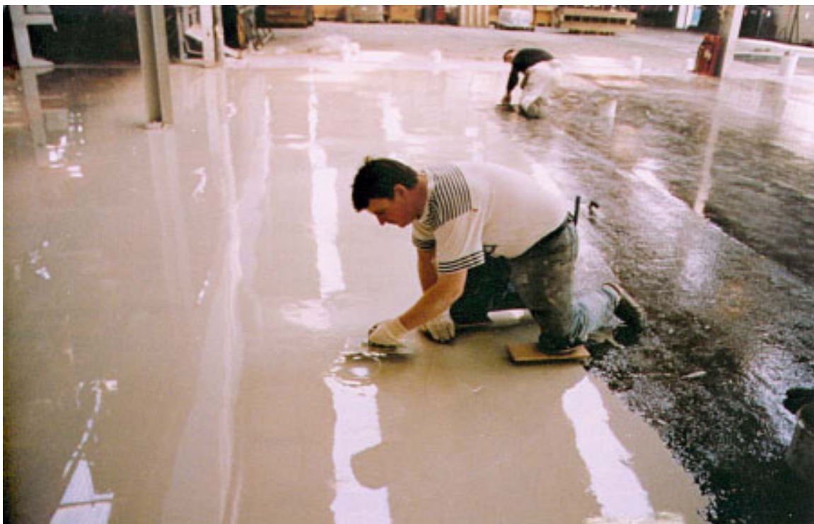
Ici les reprises sur les zones à manques, l'opérateur est agenouillé sur les planchettes et reprend à la lisseuse plane les manques.
