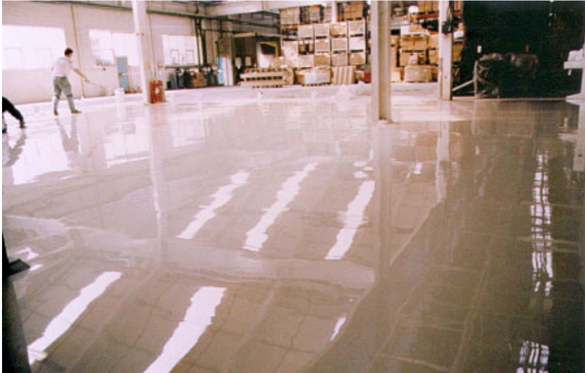
On voit ici une vue du sol en phase de dé bullage avec le rouleau à picots
