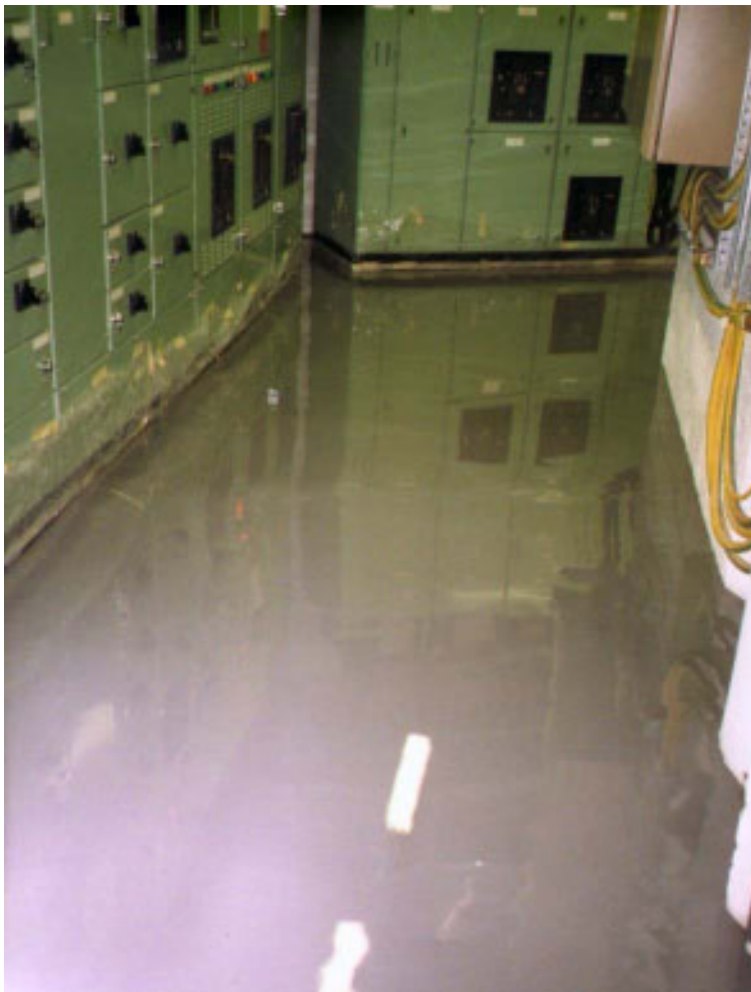
Une vue du sol terminé, qui sera sec en 3 heures 30 mn
