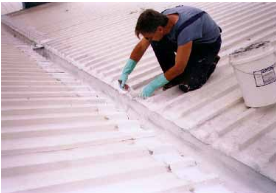
ICI UNE VUE DE L'OPERATEUR EN COURS D'ELABORATION DE LA JONCTION TOITURE / CHENAUX AVEC « Poly-Tech »
