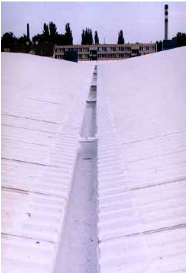
VUE GENERALE DE L'OUVRAGE REALISE EN QUELQUES JOURS
