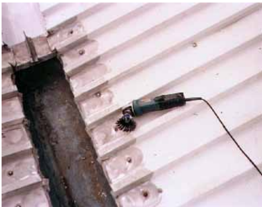
PREPARATION DE SURFACE AVEC UNE BROSSE ROTATIVE
