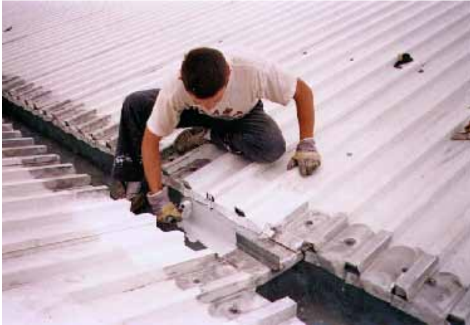
APRES NETTOYAGE ET SECHAGE, ENDUCTION DU PRIMAIRE « Uni-Tech GP Primer »
