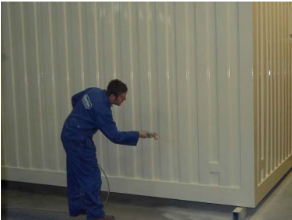
UNE VUE DE L'OPERATEUR EN COURS D'ENDUCTION DU « CORRO-TECH WB » AU PISTOLET AIRLESS Une couche de 60 \mu sera déposée ainsi en primaire.
