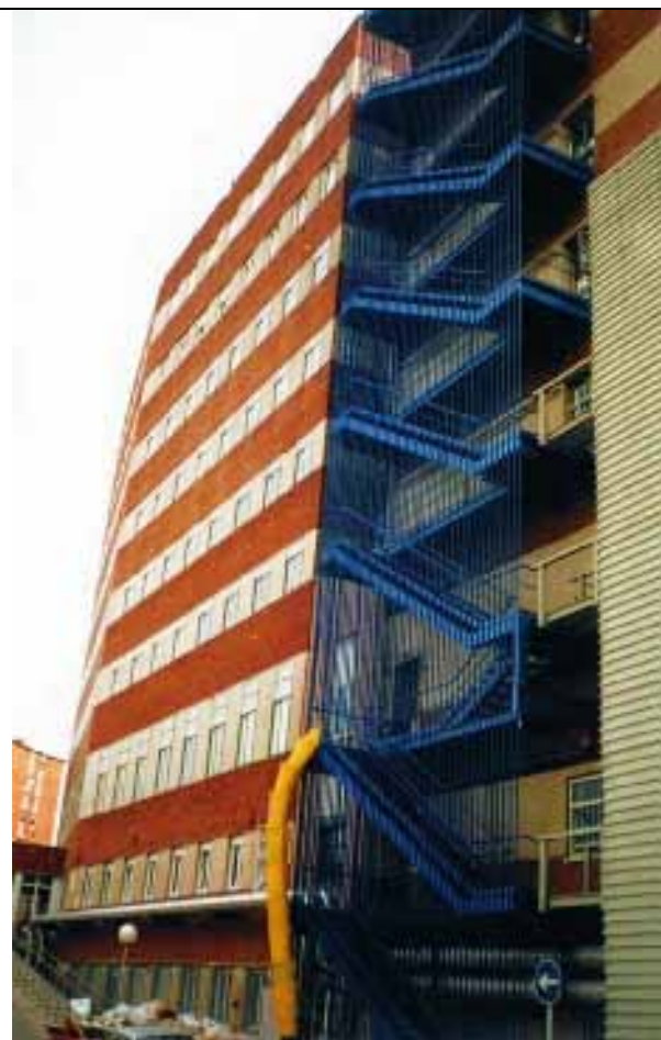
Vue de la cage d'escalier après traitement
