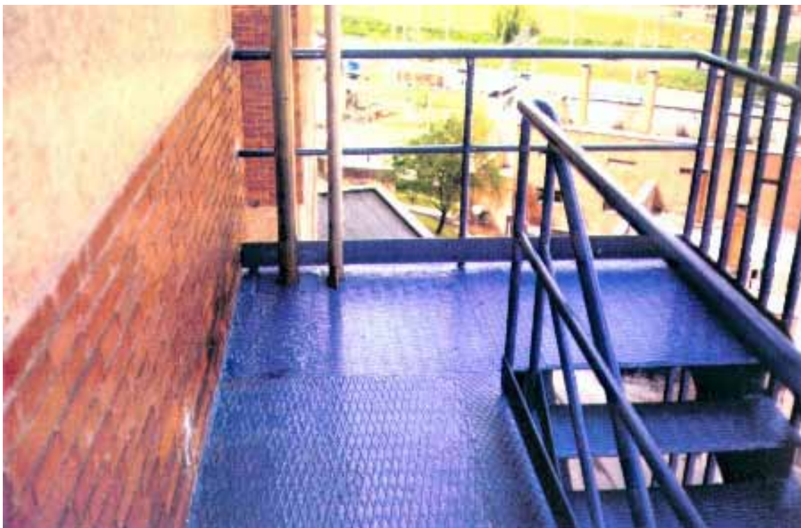
Ici après un passage à la brosse d'une couche de 125 \mu de « Corro-Tech GP » Et d'une couche de finition Bleue de 40 \mu de « Uni-Tech UV » qui permettra à cet équipement fixe d'extérieur une tenue aux intempéries pour une durée de vie de plus de 10 ans.
