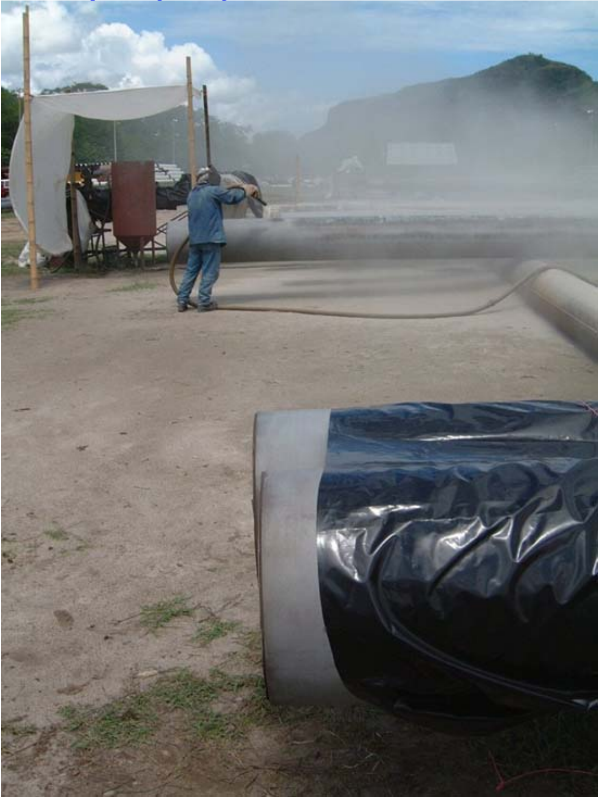
Une vue du poste de grenailage (standard SA 2 -00)
