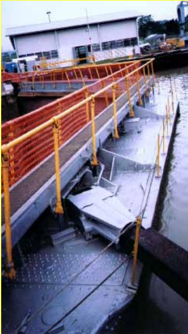
VUE DE L'OUVRAGE APRES INTERVENTION
