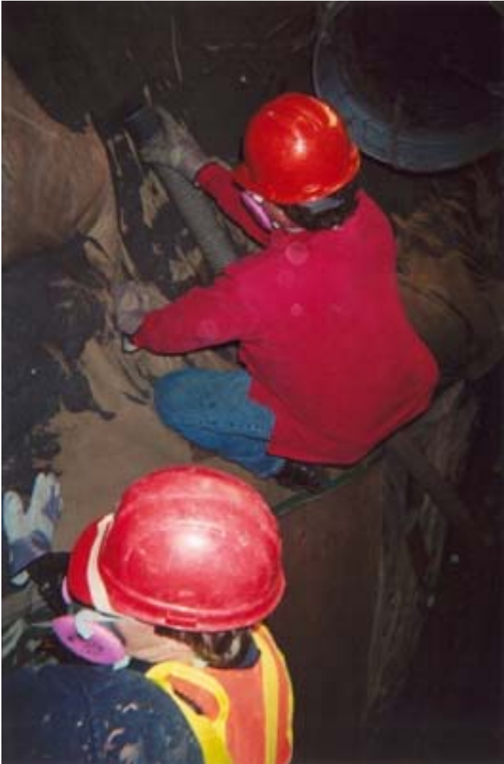
Une vue du dépoussiérage des partie sablées
