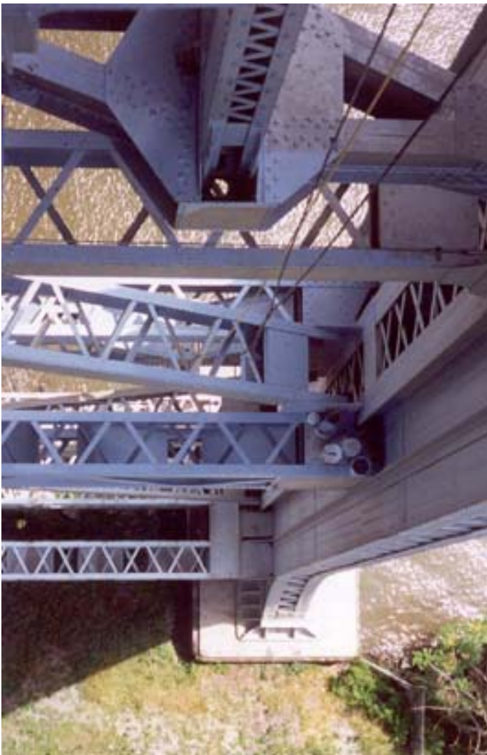
Une vue d'ensemble du chantier Nord-Est
