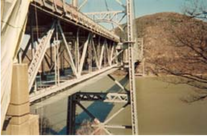
Une vue du chantier Sud-Est
