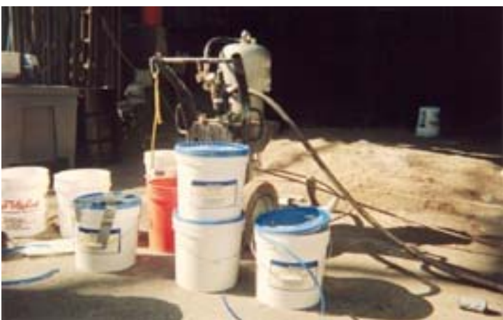
Une vue d'une des 25 stations Airless qui ont été nécessaires pour la réalisation du chantier
