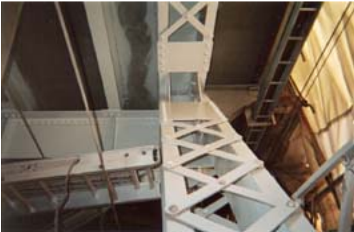
Une vue des partie traitées
