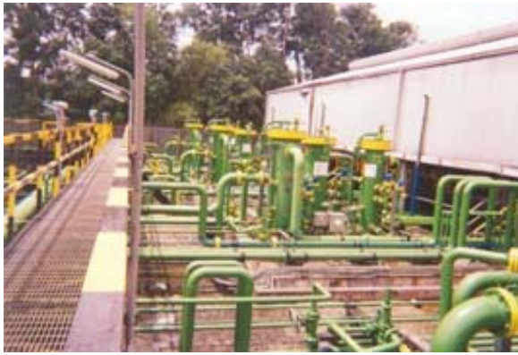
Vue d'une partie du réseau et des tuyauteries refaites
