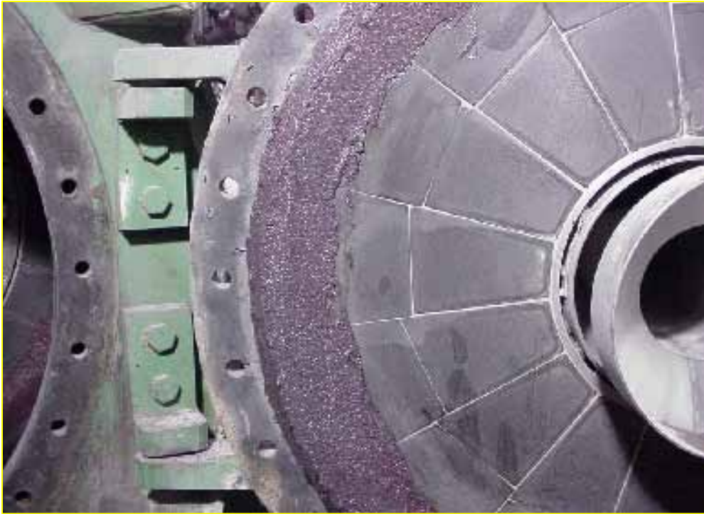
Vue de l'ouvrage après ragréage CERAMI-TECH HG
