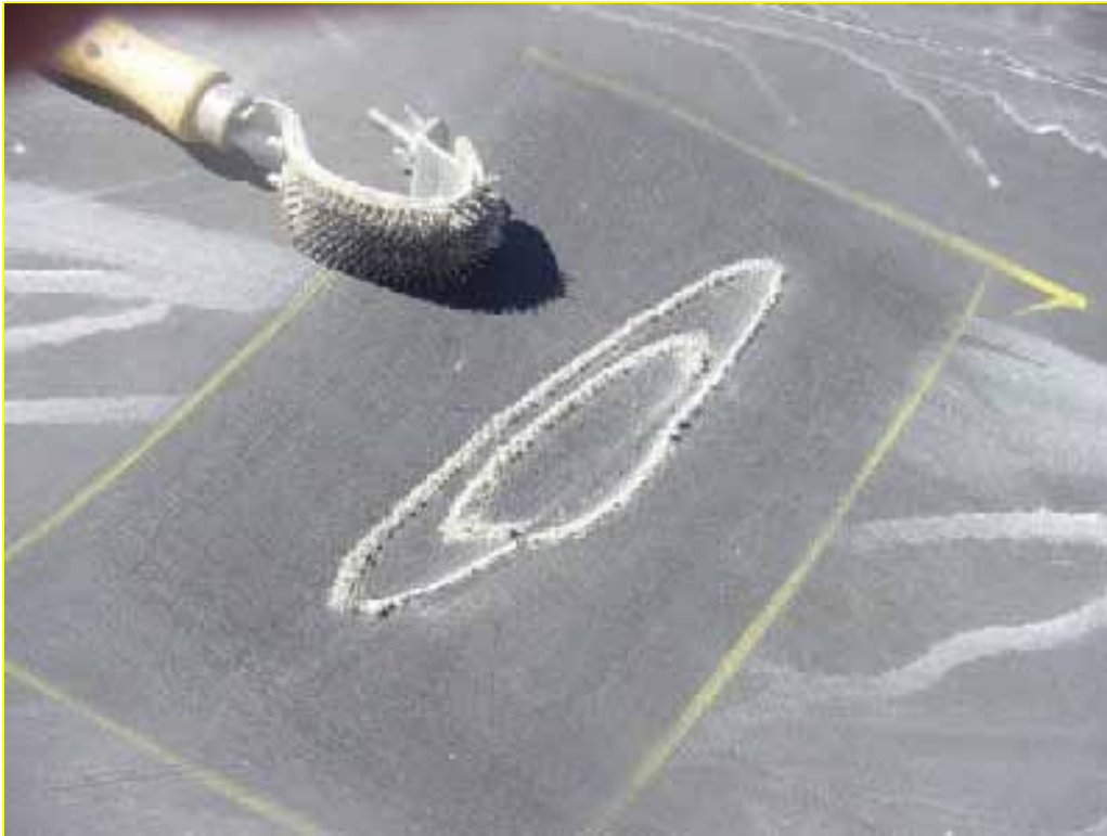
Préparation de la surface avec rape spéciale à caoutchouc
